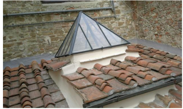
La lucarne et la toiture restaurés
