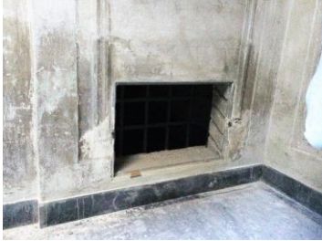
L'ancienne prise d'air avant sa restauration.
