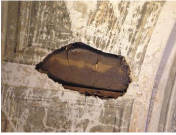
Le peintures de la voutes intierement restituées
