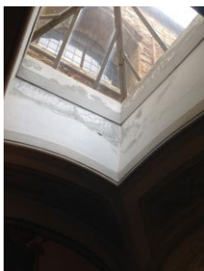
L'intérieur de la lucarne à restaurer
