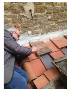
L'architecte Lazzeroni inspecte la toiture
