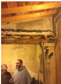
Le père Massimiliano dans le vieux couloir
