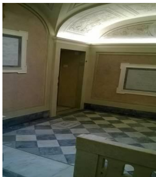
Les marbres du sol nettoyé à l'acide
