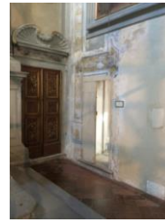
Chapelle du Sacré Cœur – Le mur mitoyen de la chapelle de Caroline, endommagé.
