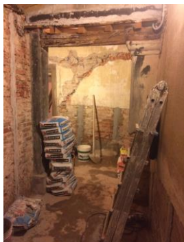
Le couloir avant les travaux
