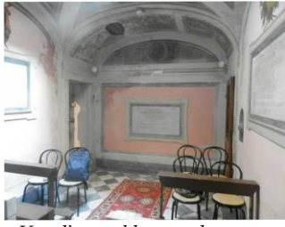
Vue d'ensemble avant les travaux
