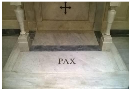
Nouveau marbre qui reintgre la discontinuité du sol là où un trou était caché par un tapis
