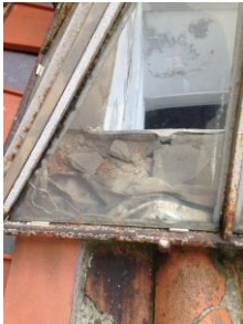
La lucarne à restaurer
