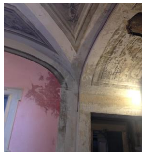
Dégats causés par l'humidité
