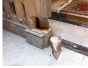
Balustrade cassée avant sa réparation
