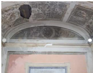
Le plafond de la voûte s'effondre
