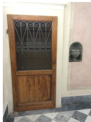
La porte restaurée qui s'ouvre au couloir.
