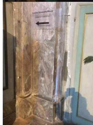
Les murs endommagés aux deux cotés de la nouvelle entrée ont été protegés par la pose de panneaux en plexiglas.
